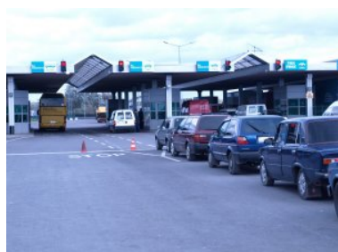
Drogowe przejście graniczne w Dorohusku
