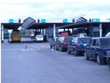
Drogowe przejście graniczne w Dorohusku
