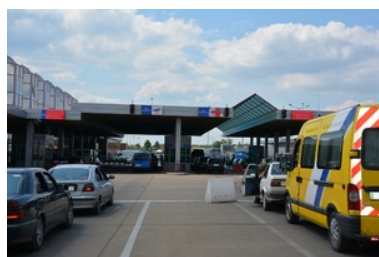
Drogowe przejście graniczne w Dorohusku
