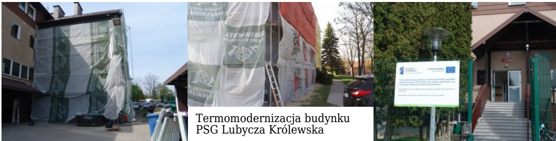
Termomodernizacja budynku PSG Lubycza Królewska
