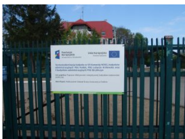
Termomodernizacja budynków PSG Skryhiczyn
