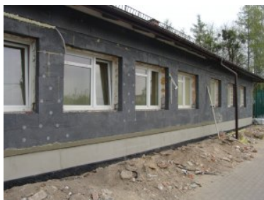
Termomodernizacja budynku nr 63 Komendy NOSG w Chełmie
