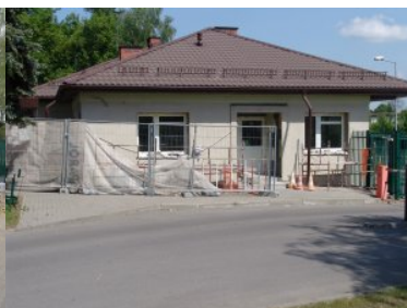
Termomodernizacja budynku nr 63 Komendy NOSG w Chełmie
