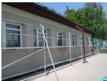
Termomodernizacja budynku nr 63 Komendy NOSG w Chełmie
