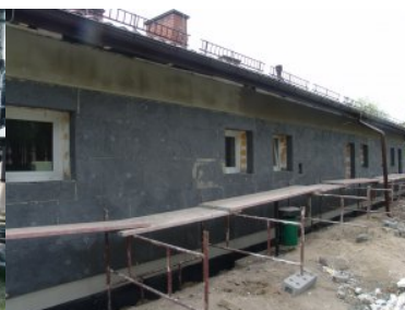
Termomodernizacja budynku nr 63 Komendy NOSG w Chełmie
