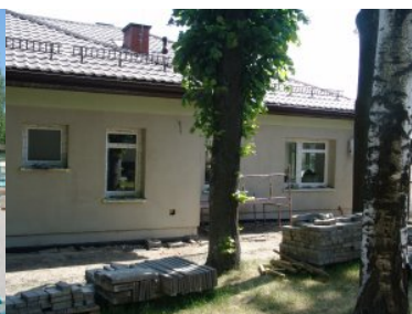
Termomodernizacja budynku nr 63 Komendy NOSG w Chełmie
