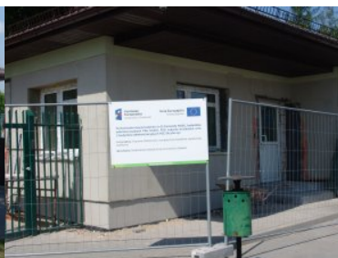
Termomodernizacja budynku nr 63 Komendy NOSG w Chełmie
