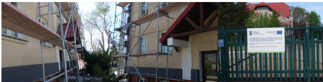
Termomodernizacja budynków PSG Skryhiczyn
