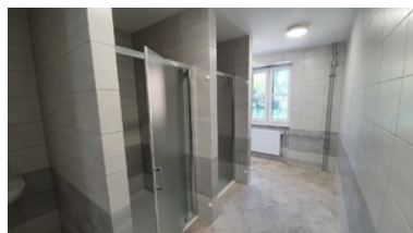
Modernizacja budynku Placówki Straży Granicznej w Kodniu
