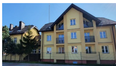
Modernizacja budynku Placówki Straży Granicznej w Kodniu
