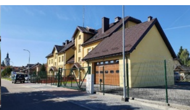
Modernizacja budynku Placówki Straży Granicznej w Kodniu
