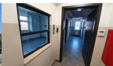
Modernizacja budynku Placówki Straży Granicznej w Kodniu
